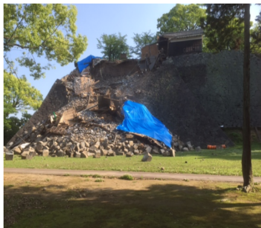
熊本城の崖崩れ
